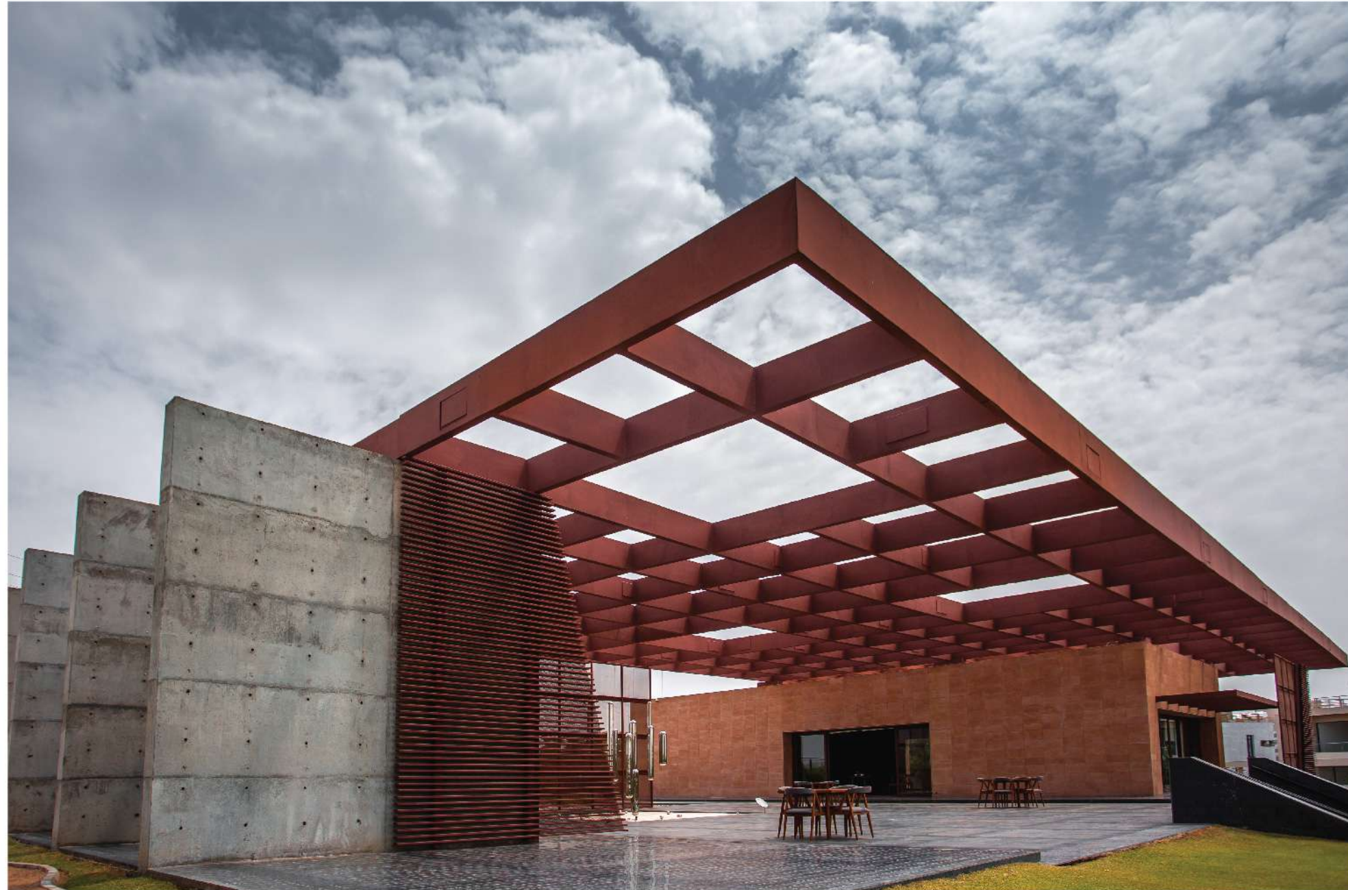
Actual Site Image
